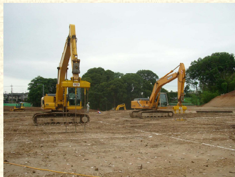
凝灰質粘土貫入注入改良
