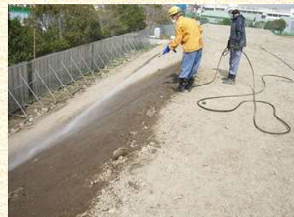
法面での液体散布
