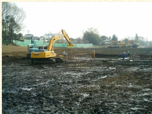
腐植土貫入注入改良
