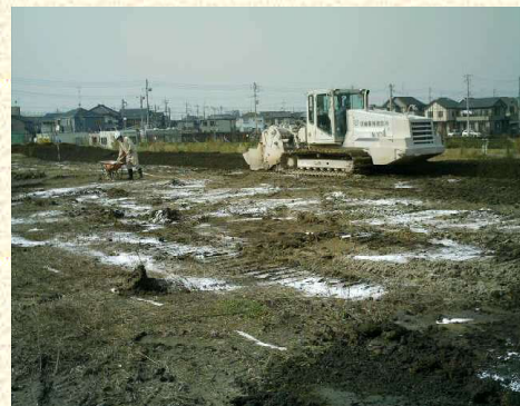
シルト粘土混合攪拌改良
